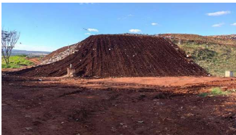
Figura 9 – Recobrimento dos resíduos
