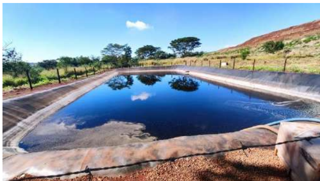
Figura 16 – Lagoa de armazenamento de chorume
