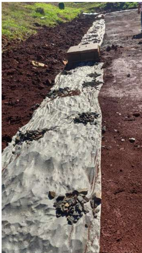
Figura 11 – Sistema de drenagem interna de percolados
