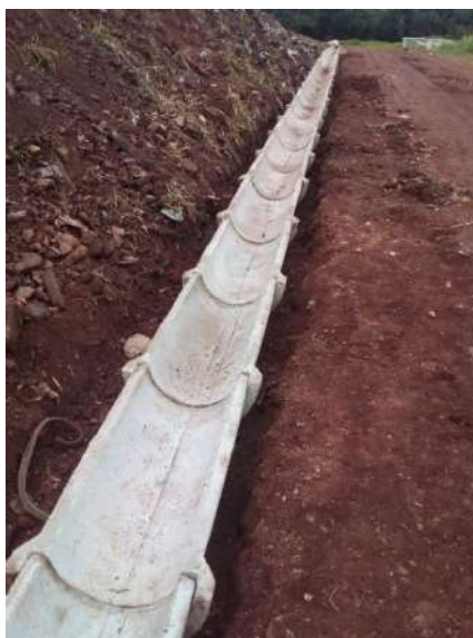
Figura 13 – Sistema de drenagem superficial
