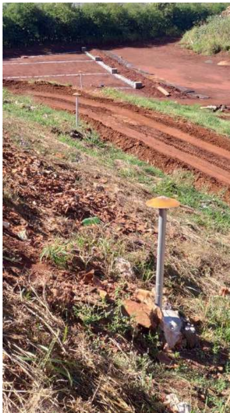
Figura 15 – Sistema de drenagem interna de gases
